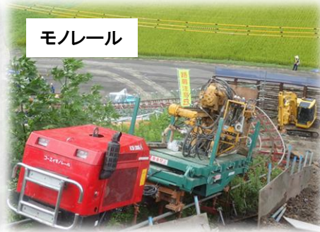
鉄筋挿入工
